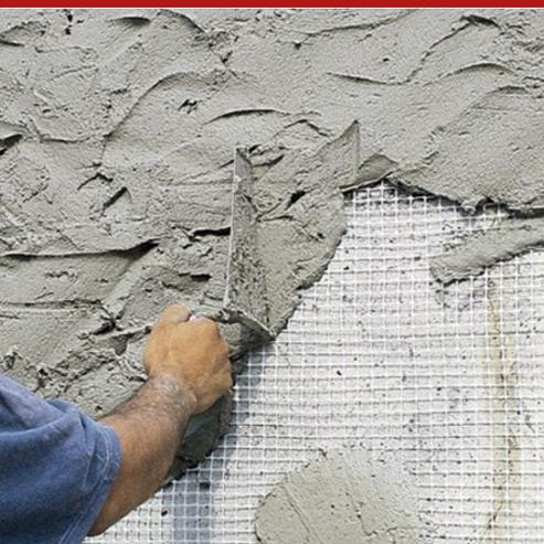
Redes de armadura contra fissuras, com base de fios em fibra de vidro alcalino-resistentes, para melhor distribuir as tensões e evitar fissuras de retração decorrentes de variações de temperatura devido a falta de homogeneidade plana, etc. São disponíveis em 3 diferentes tipologias: a versão de 60 g/m<sup>2</sup>, com uma malha quadrada de 2,7 x 2,7 mm, é ideal para microalisamentos armados. O rolo padrão tem 1 m de altura por 100 m de comprimento.
