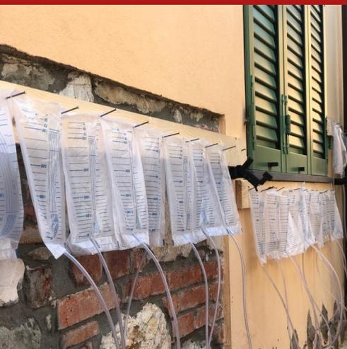
Saco graduado em polietileno, a fixar mediante pregos a oportuno suporte de madeira ou alvenaria, necessário para a realização de barreiras químicas contra a ascensão capilar da humidade com o método de lenta difusão.
