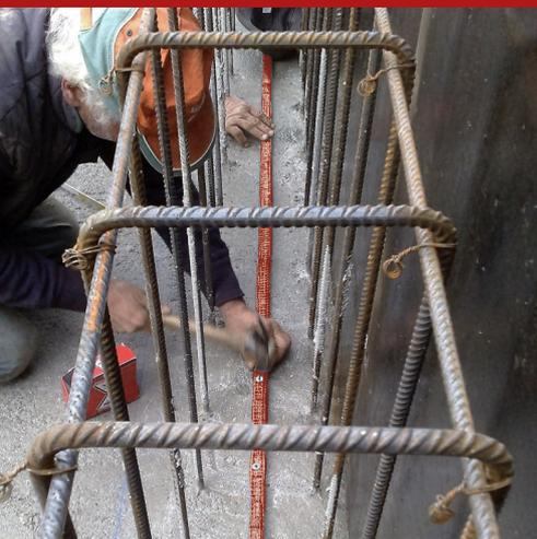
Junta waterstop vedante hidroexpansiva, preformada, para juntas de construção com segura vedação hermética em estruturas, alvenarias e fundações, realizada com uma mistura de bentonita de sódio, borracha hidroexpansiva e polímeros especiais de agregação ("hidrocarbonetos"), especificamente concebido para uso em contacto com água salgada ou percolados orgânicos. Clayseal 25.20 SW tem uma secção retangular de 25x20 mm, embalada em rolos de 5 m cada um.
