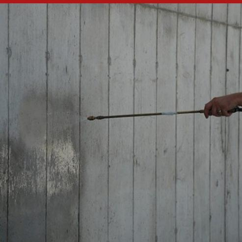
Consilex No-Rust é um potente inibidor de corrosão, não tóxico, para aplicar sobre as superfícies das estruturas de betão e que, graças à sua natureza química especial, migra para dentro do conglomerado e deposita sobre as suas armaduras internas substâncias particulares que preservam a sua integridade no decorrer do tempo, inibindo os fenómenos de oxidação.
