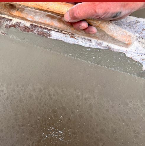
Floor Level é uma argamassa autonivelante cimentícia, modificada com polímeros e reforçada com fibra, de aderência e endurecimento rápido, para utilizar na regularização e alisamento de espessuras compreendidas entre 3 e 20 mm antes da colocação de pavimentos, tornando-as adequadas para receber qualquer tipo de revestimento.
