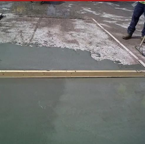
Floor Level SFR é uma argamassa cimentícia autonivelante, polímero modificado, reforçada com fibras Readymesh MR-060, de pega acelerada e endurecimento rápido, utilizável para regularizações planas com espessuras de 3 mm a 25 mm, antes da colocação de pavimentos, tornando-o adequado para receber qualquer tipo de cobertura.
