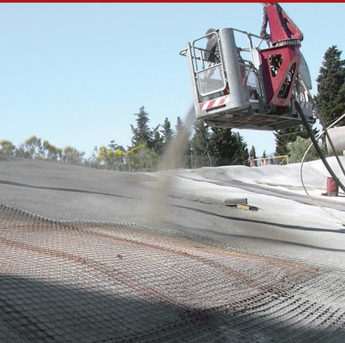
Aditivo polivalente em pó fibro-reforçado, a adicionar a uma mistura correta de ligantes e agregados, para preparar argamassas, microbetões e betões reoplásticos, tixotrópicos, com encolhimento controlado, com elevados desempenhos mecânicos, químicos, impermeáveis.
