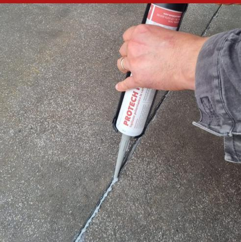
Selante de poliuretano, monocomponente, de cura húmida e endurecimento rápido, com módulo de elasticidade médio/alto, permanentemente elástico, de elevada dureza na superfície, resistente ao rasgo e aos agentes atmosféricos, pode ser pintado. Ideal para selagem de juntas de dilatação em terraços e varandas, para enchimento de juntas em paredes pré-fabricadas e em materiais de madeira, aço, alumínio, cobre, plástico, reboco, etc.
