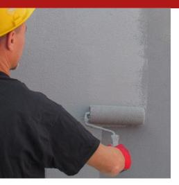
Acabamento monocomponente colorido em dispersão aquosa para proteção opaca de superfícies de concreto e suportes cimentícios, revestimentos de parede e pisos devidamente preparados e imprimados. O produto é um sistema de pintura adequado para ambientes com presença de alimentos, que pode ser utilizado para proteger paredes e tetos que atendam ao protocolo HACCP, a fim de evitar possíveis contaminações alimentares.
