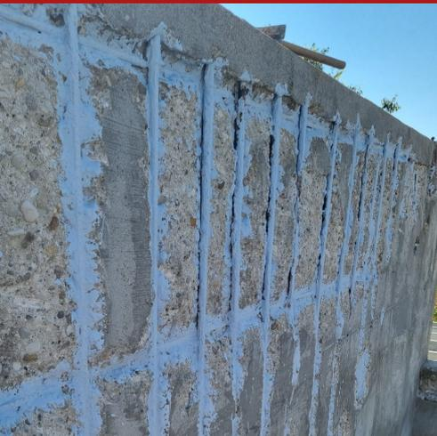
Pasta de cimento em pó monocomponente, passivante, azul claro, a adicionar com água, modificada com agentes superpozolânicos, resinas de flexibilização e inibidores de corrosão, para o tratamento passivante dos ferros de armadura oxidados, no restabelecimento de betão degradado.
