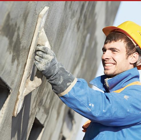
Alisante fino, bicomponente, tixotrópico, reoplástico, compósito, “multiuso”, de rápida solidificação. Ideal para alisamento milimétrico e cosmético de artefactos e obras de betão nas intervenções de restabelecimento estrutural e/ou funcional; adequado também para o alisamento de fachadas de edifícios civis com presença parcial ou total de revestimentos plásticos de paredes.
