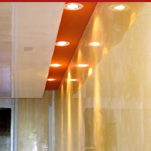
Revestimento-acabamento com espessura, espalhável com imitação de mármore, pode ser obtido na forma brilhante ou opaca, para exteriores e interiores, transpirante e hidrorrepelente, a base de cal apagada, pó de mármore micronizado e agentes específicos, inatacável por mofo, não absorvente com relação a sujidades. Disponível em várias tintas, com amplas alternativas de tonalidade, formulável por encomenda.
