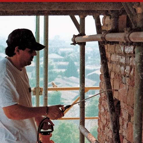
Solução reativa de silicatos minerais, capaz de formar, por reação com os sais e os hidratos de cálcio presentes nas alvenarias, compostos ligantes e estabilizantes, específica para os tratamentos endurecedores, preliminares às subseqüentes operações de reboco ou de alisamento, de estuque e argamassas de espalhar, pulverulentos e invólucros de alvenaria em geral, nas intervenções de bioconstrução e na restauração de edifícios históricos e monumentos.
