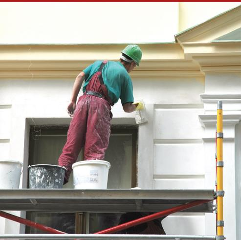
Gesso natural, protetor, decorativo, respirável, pigmentado, não tóxico, anti-mofo, com silicatos de potássio estabilizados, para interiores e exteriores. Formulação substancialmente mineral que, graças ao pH alcalino natural do silicato de potássio, desenvolve uma forte ação antibacteriana e antimoho. Sanaxil I é um produto versátil e válido em vários campos de aplicação: em intervenções em edifícios verdes, em novas construções e na restauração de edifícios de época e monumentais.
