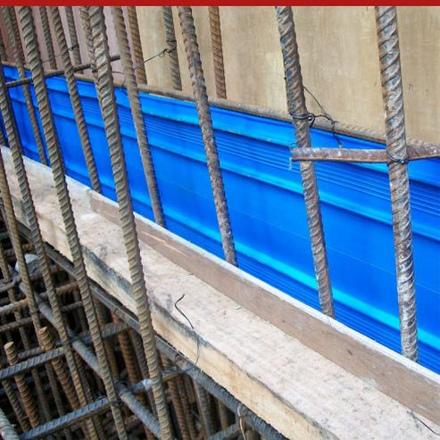
O waterstop Sealpvc SF 240 é um perfil impermeável de PVC, não hidrófilo expansivo, com 24 cm de largura e elevado módulo de elasticidade. É utilizado em juntas estáticas para juntas de betonagem horizontais (lajes), em estruturas de betão apoiadas na sub-base por baixo da armadura.
