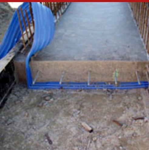
O waterstop Sealpvc SF 250 Bulb é um perfil impermeável de PVC, não hidrófilo expansivo, com 25 cm de largura, bolbo central e elevado módulo de elasticidade. É utilizado em juntas dinâmicas para juntas de betonagem horizontais (lajes) ou verticais (paredes elevadas), em estruturas de betão apoiadas na sub-base por baixo da armadura, em posição central ao jacto.
