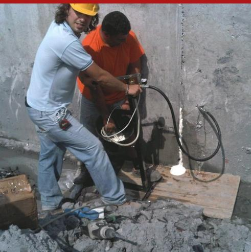
Bomba manual com pistão único, de escorvamento, com efeito simples, para injetar resinas fluidas de tipo poliuretano e epóxi. A pressão máxima distribuída pela bomba é de 40 bar. A capacidade é de 1 litro em 55 ciclos.
