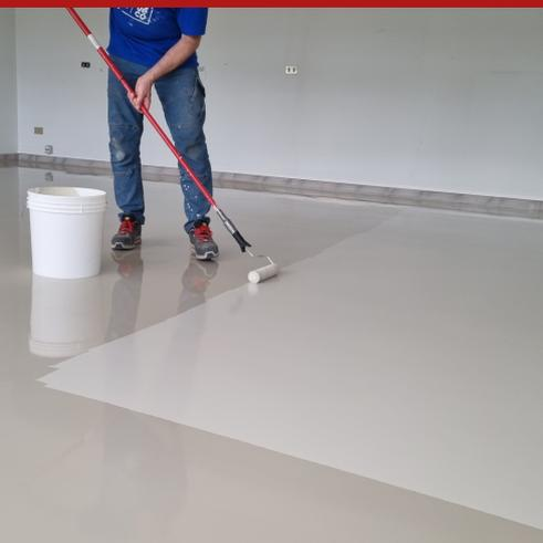
Acabamento colorido bicomponente, à base de resinas epóxi em dispersão aquosa. Ideal para o revestimento pigmentado de pavimentos industriais e de estruturas de betão em geral. As superfícies tratadas com Syntech Pavicrom são fáceis de limpar e oferecem excelente resistência ao desgaste mecânico; para além disso, apresentam elevada resistência à água, às soluções alcalinas, aos detergentes e aos hidrocarbonetos (óleo, gasóleo, gasolina, etc.).
