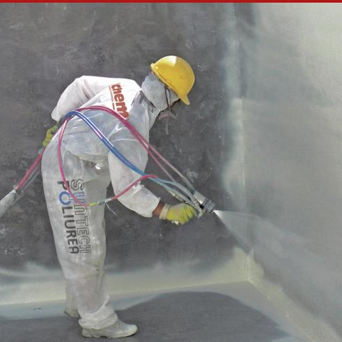
Syntech Poliurea Spray - FC é uma poliureia pura aromática estudada especificamente para o contacto com substâncias alimentares e água potável. 100% sólida, não contém VOC e é aplicável apenas por pulverização por meio de máquinas bímixers adequadas. É do tipo aromático e é caracterizado por um alto grau de alongamento. É um elastómero de revestimento obtido da reação de um isocianato de tipo aromático com uma amina.
