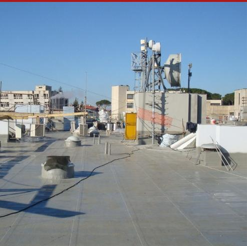
SYNTECH POLIUREA PRIMER é uma fórmula de dois componentes a base de resinas epóxi em combinação com endurecedores amínicos cicloalifáticos. É caracterizado pelos altos valores da capacidade de penetração e consolidação, especialmente com referência às superfícies de betão e é indicado também para a maior parte de suportes e superfícies presentes na construção. Específico para a preparação de superfícies antes do seu revestimento com SYNTECH POLIUREA SPRAY.
