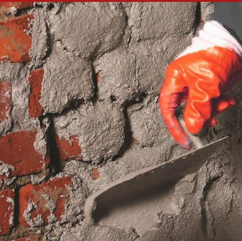
Pré-mistura monocomponente para a criação, com adição apenas de água de amassamento, de camadas de reboco respiráveis, desumidificantes, preparatórias para a aplicação de rebocos de reparação, desumidificantes, termo-isolantes e anti-condensação; nomeadamente Intosana, Sanatigh, Sanawarme e Caleosana, rebocos concebidos especificamente para a salubridade de novos edifícios, edifícios existentes, intervenções em edifícios sustentáveis e reabilitação de edifícios de valor histórico e patrimonial.
